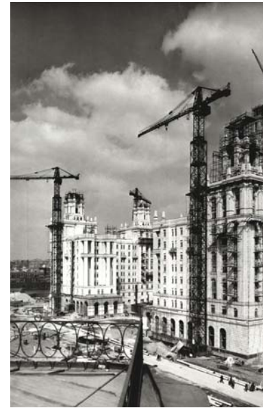
Завершение строительства жилых корпусов
