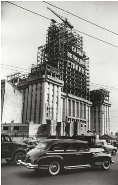
27-этажное здание (172 м) на Смоленской площади. При строительстве применен новейший метод организации строительных работ: за 110 дней был возведен металлический каркас на всю высоту здания, а затем происходило бетонирование каркаса. Оно началось с последнего этажа и по мере застывания бетона, опалубка спускалась на следующий этаж. Лицевой фасад, на высоте 114 м украшает герб СССР (1948–1953)
