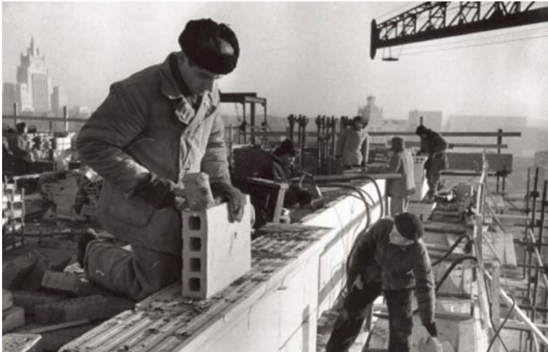
Облицовка стен керамическими пустотелыми блоками
