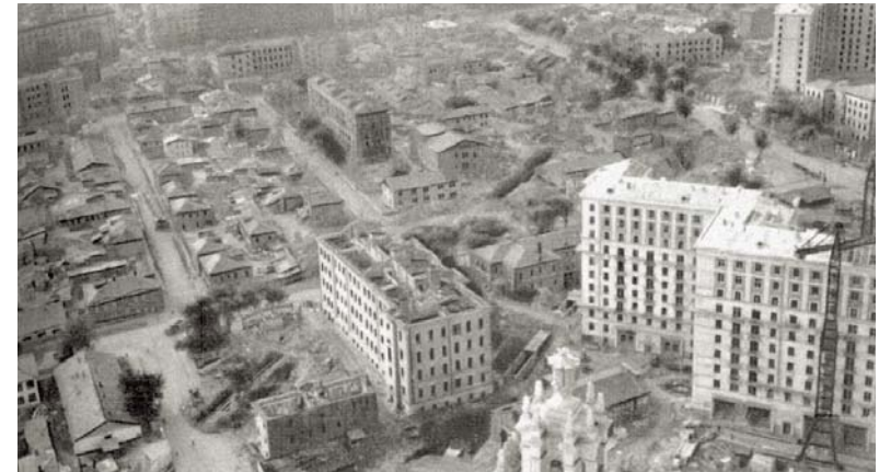
Прокладка магистрали – будущего Кутузовского проспекта. Со смотровой площадки 29-го этажа гостиницы
