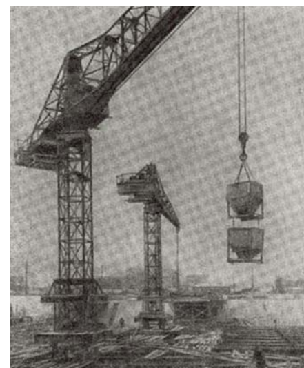
Бетонирование стен фундаментов гостиницы на Дорогомиловской набережной с помощью крана УБК-5-49 и бадей-бункеров (из архива Н.Кружкова)
