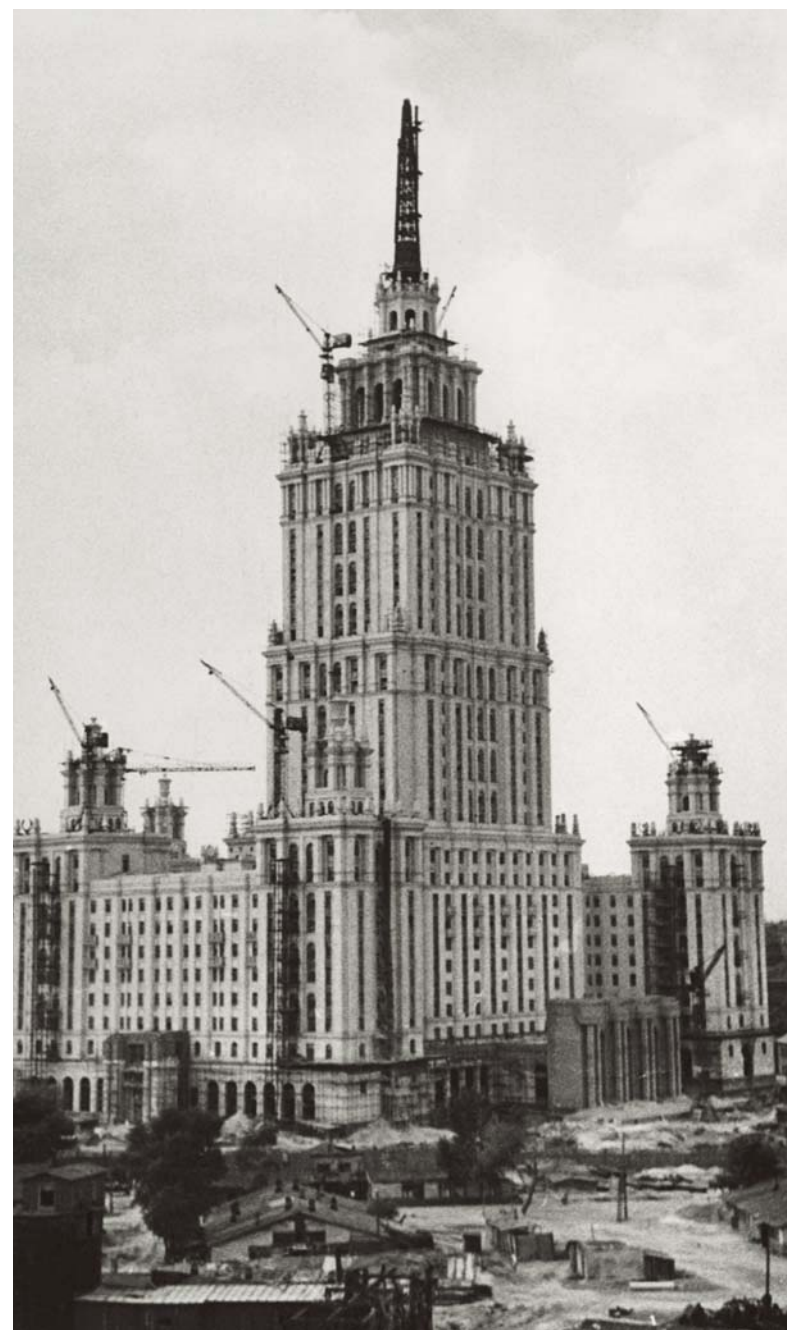
Строительство гостиницы близится к завершению. Середина 1950-х
