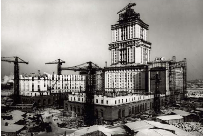
Строительство гостиницы на Дорогомиловской набережной. Начало 1950-х
