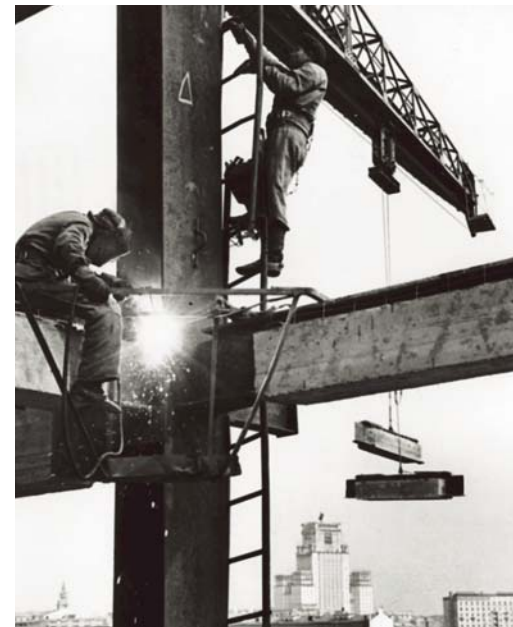
Работа монтажников-высотников на строительстве 26-го этажа гостиницы
