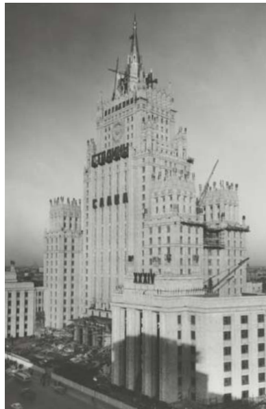
27-этажное здание (172 м) на Смоленской площади. При строительстве применен новейший метод организации строительных работ: за 110 дней был возведен металлический каркас на всю высоту здания, а затем происходило бетонирование каркаса. Оно началось с последнего этажа и по мере застывания бетона, опалубка спускалась на следующий этаж. Лицевой фасад, на высоте 114 м украшает герб СССР (1948–1953)
