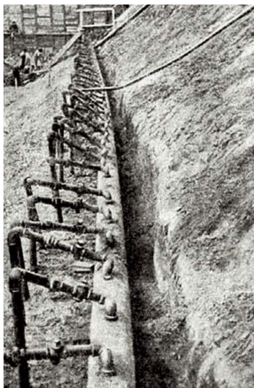
Котлован огражден подземным частокотлом иглофильтров, присоединенных к общему водосборному коллектору. 1949
